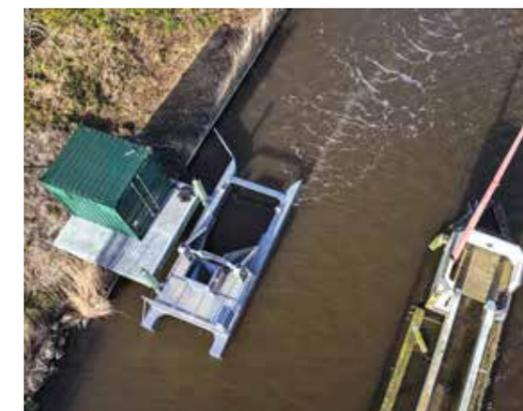
*In alto: La Bubble Barrier e il sistema di captazione visti dall'alto.*
